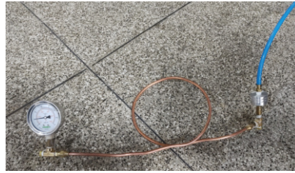
Figura 9. Teste de vazamento da linha do manômetro. É possível observar o manômetro marcando 140 psi (esquerda) e a linha de ar comprimido em azul, conectada ao bulkhead com rosca NPT (direita)
