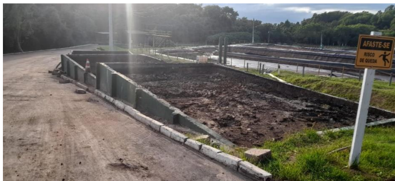
Figura 1 – Leito de Secagem da Gordura de Caixas de Gordura na CTR Marca
