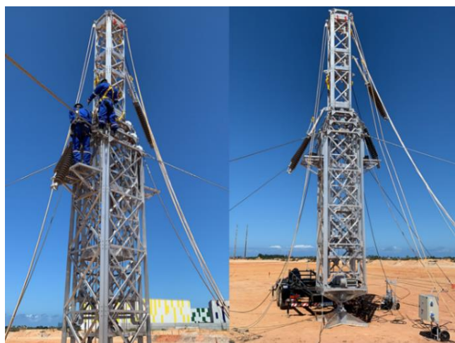
Figura 9. Montagem e instalação da Torre em configuração tipo Canadense
