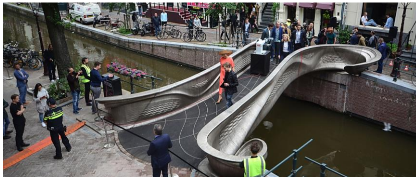
Figura 5. Ponte fabricada pela MX3D e instalada em Amsterdã, Holanda (MX3D, 2021).
