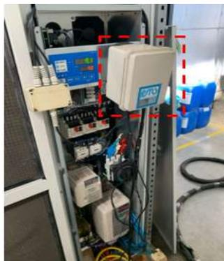
Figura 2. Instalação Analisador Trifásico
