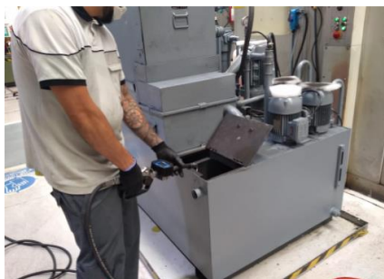
Figura 1: Bombeamento de óleo e água diretamente no reservatório
