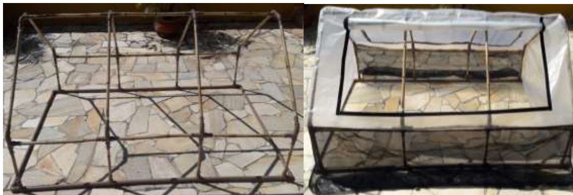
Figura 7 - Estrutura da estufa após a montagem e travamento (Os Autores, 2020)
