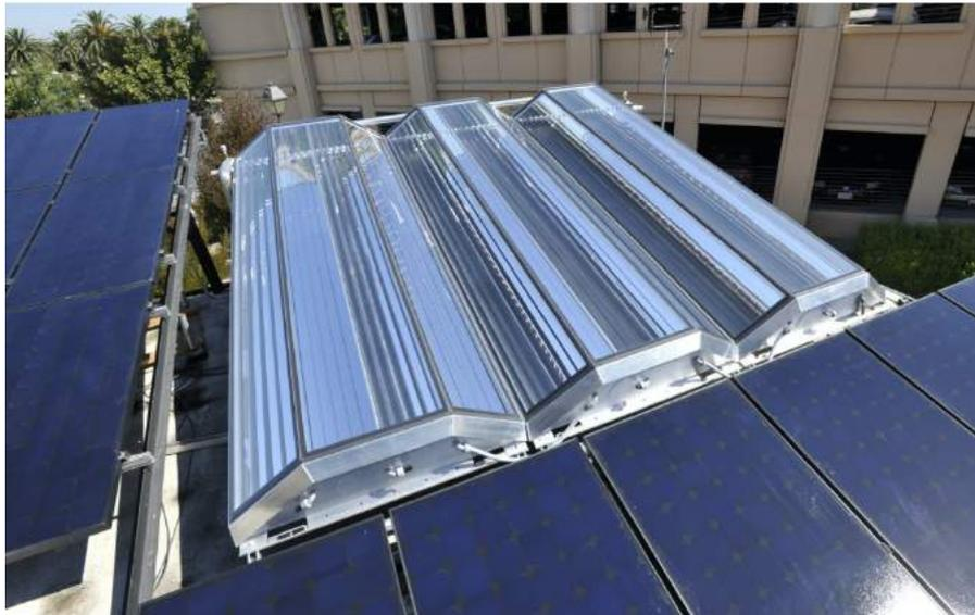
Figura 7. Imagem detalhada do microconcentrador desenvolvido pela ANU em parceria com a Chromasun ao lado de um sistema PV convencional (Everett *et al.*, 2011).
