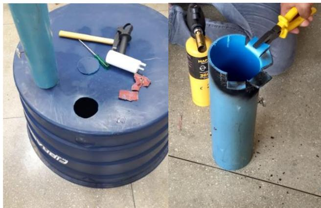
Na Figura 10 é possível verificar o resultado do processo de produção do flange. Os vãos na aureola da tubulação foram preenchidos com massa Durepox para evitar vazamentos.
