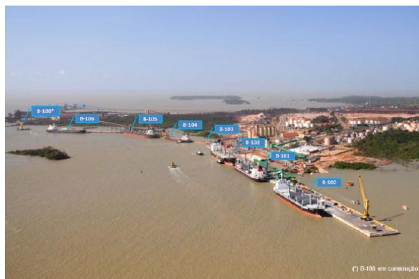
Figura 1 - Vista aérea do porto do Itaqui (Fonte: EMAP)
