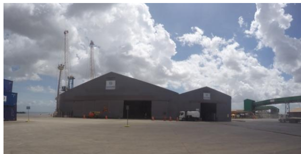
Figura 3 - Armazém da Suzano
