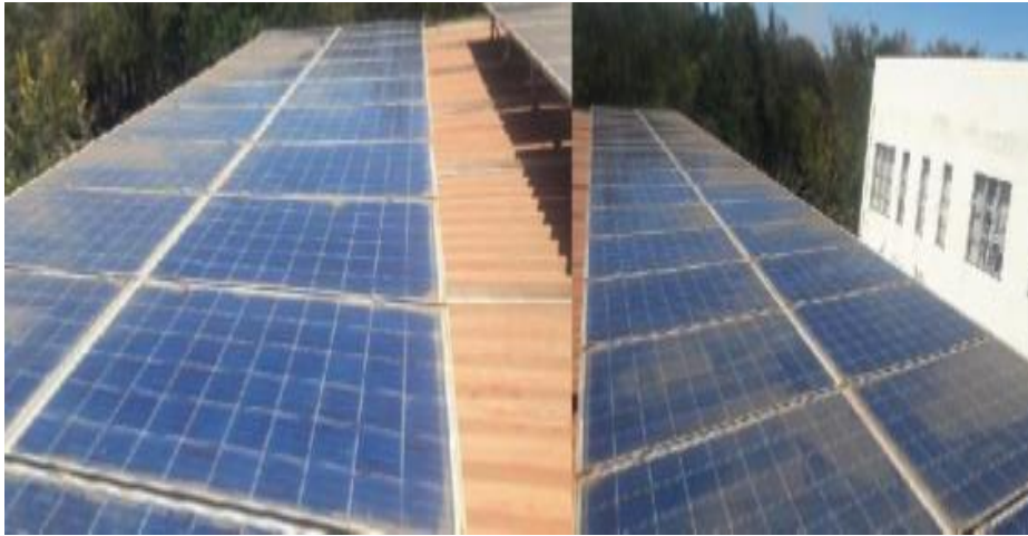
Figura 3: Módulos após a manutenção. Fonte: alsol energias renováveis
